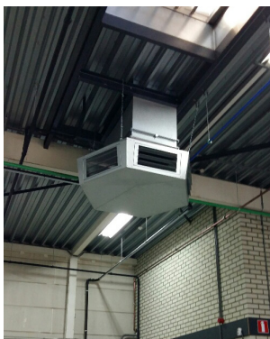
6-stronne plenum nawiewu w 6 kierunkach wyposażone w żaluzje poziome
